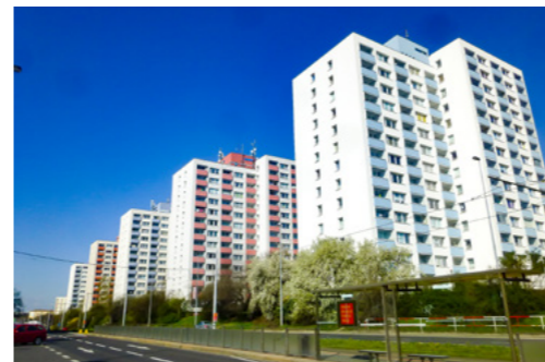
Praha 6, sídliště Červený vrch – dobrý příklad shodného řešení skupiny věžových panelových domů.
