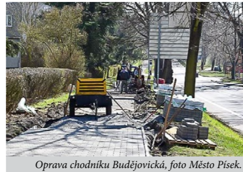
Oprava chodníku Budějovická, foto Město Písek.
