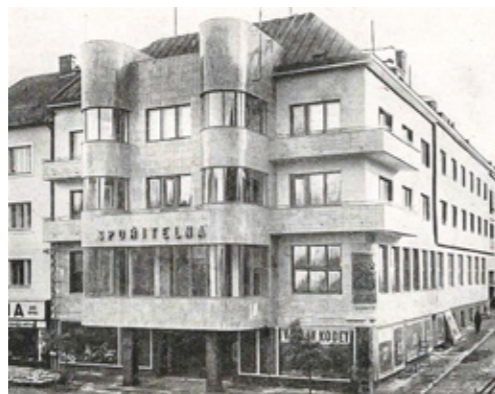
Písecká spořitelna, roh Velkého nám. a Šrámkovy ul., kde také knihovna sídlila - vchod ze Šrámkovy ulice.
