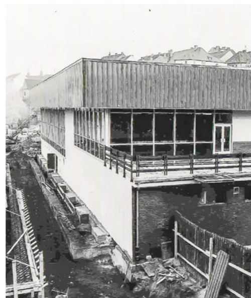
Plavecký bazén v Písku byl vybudován v roce 1983.
